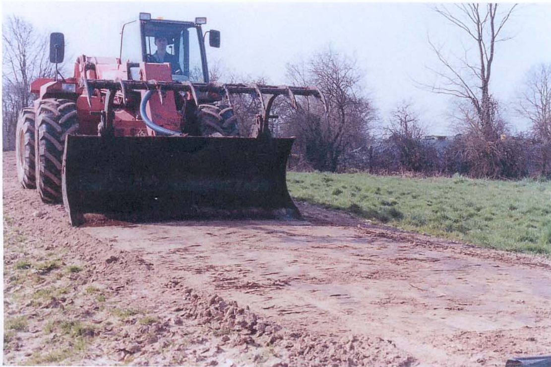
Jämna ut underlaget. Ta bort stenar från ytan.
