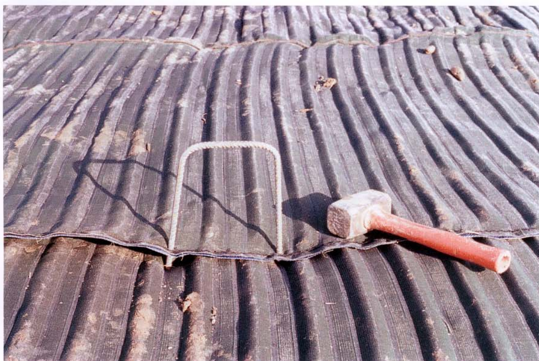
Överlappa de olika delarna. Lås fast mattorna med fästbyglarna. TexWay färdig att använda!
